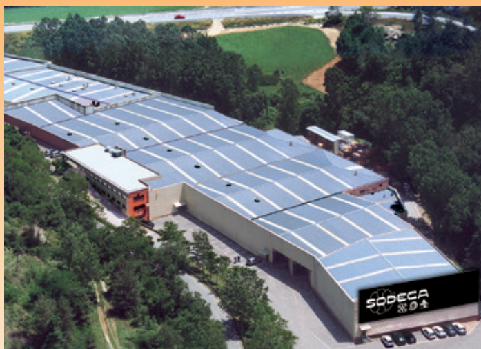
Instalaciones centrales de SODECA S.L.U., en Sant Quirze de Besora
